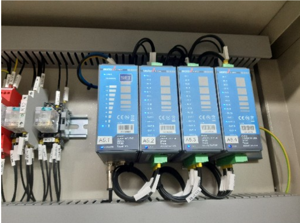
Fot 3: Sterownik E1000 - magistrala z modułami WE/WY
